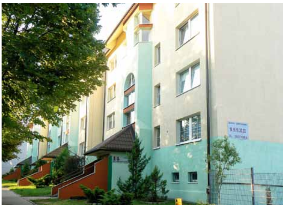
ul. Grottgera 14-22 w Gliwicach
